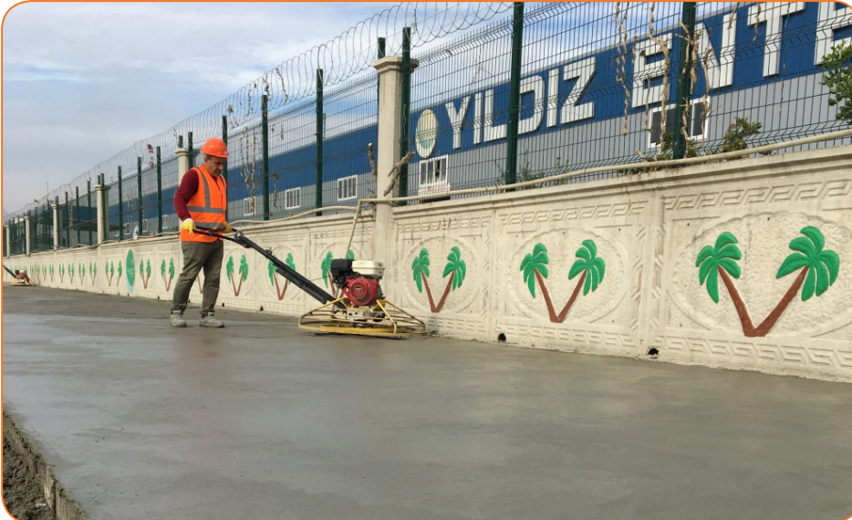
YILDIZ ENTEGRE MDF FABRİKASI SAHA BETONU İŞLERİ – MERSİN
