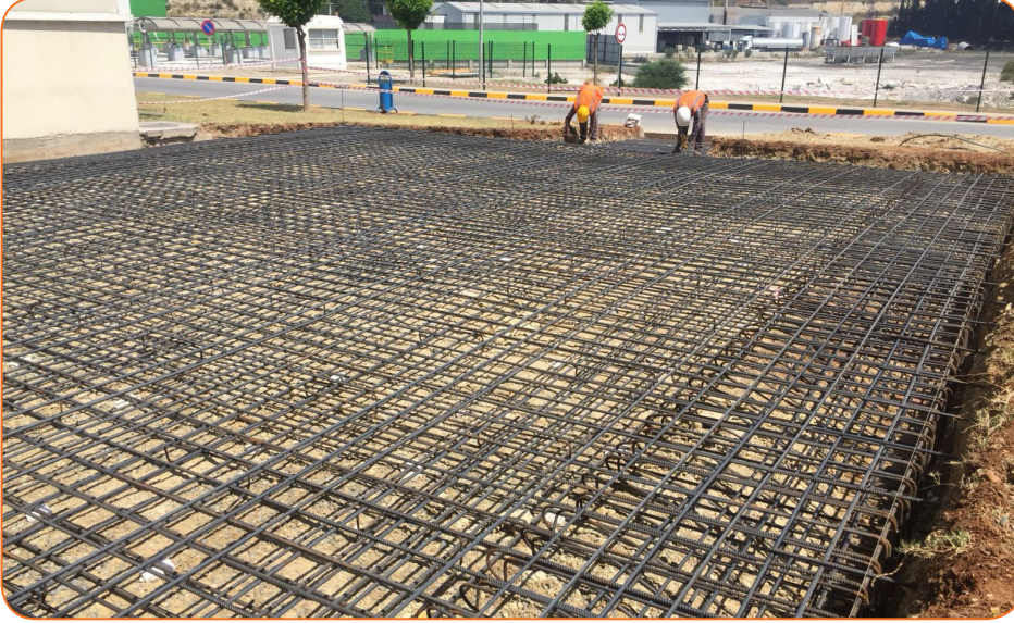
FRITOLAY TARSUS FABRİKASI KAİDE BETONU İŞLERİ – MERSİN
