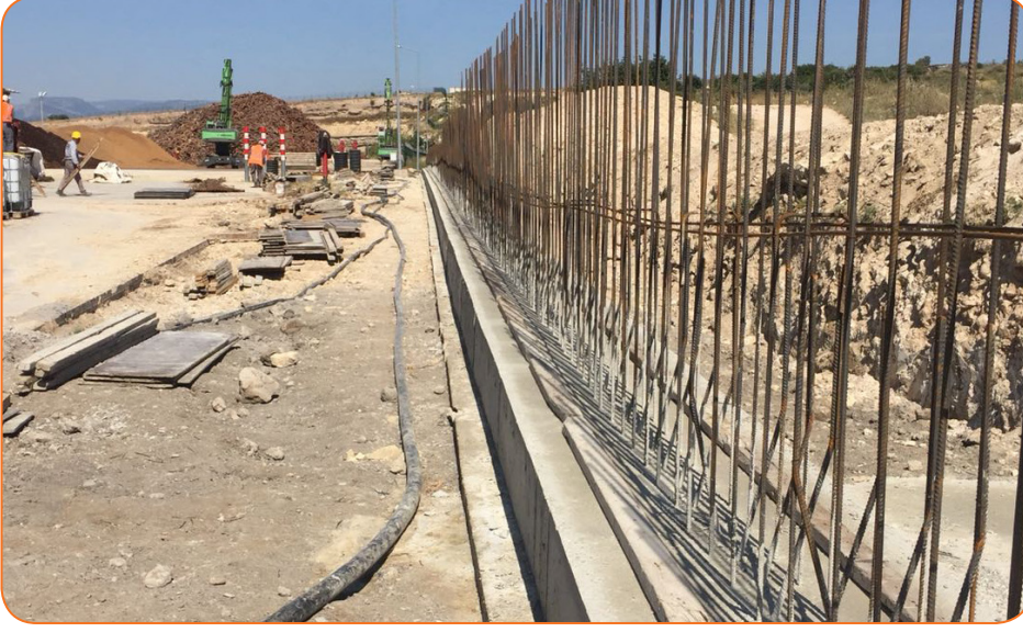
YILDIZ ENTEGRE MDF FABRİKASI PERDE BETONU İŞLERİ – MERSİN
